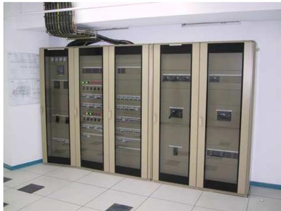
Para proteger el funcionamiento de los equipos instalados en el CPD si se produjese un corte eléctrico, se ha provisto a la sala de un sistema de Alimentación ininterrumpida (SAI o UPS).
